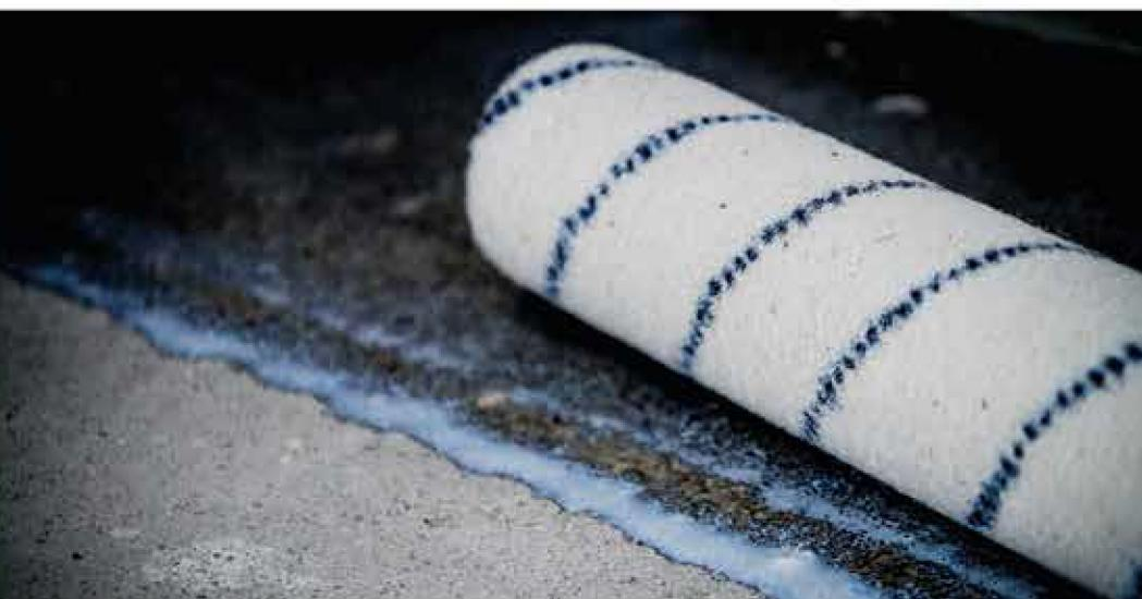
Грунтовые покрытия, или же праймеры, имеют много важных функций при сооружении пола. В первую очередь они обеспечивают оптимальное сцепление шпаклевочных смесей и клеев с полом. На гладких, уплотненных основаниях они образуют адгезионный мост, а также улучшают смачиваемость. На сильно впитывающих основаниях они уменьшают гигроскопичность. Все это уменьшает расход клея или шпаклевочной смеси. Это экономит время и деньги.
